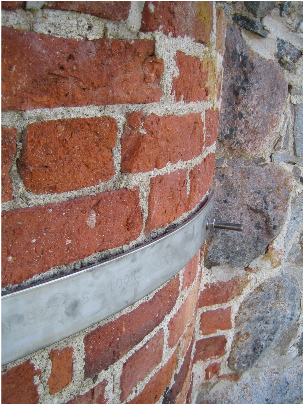
Bild 8. Järnband kring hängtorn med dess infästning. Infästning är monterad med Hilti hit-hy massa i vägg.
