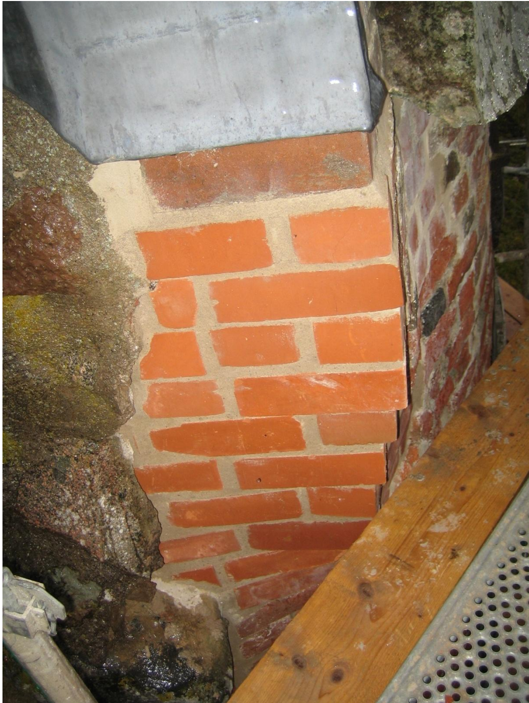
Bild 11. Lagad mur öster om hängtorn.
