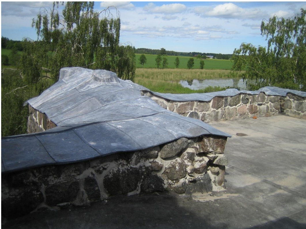
Bild 23. Färdig blytäckning i norra tornet.
