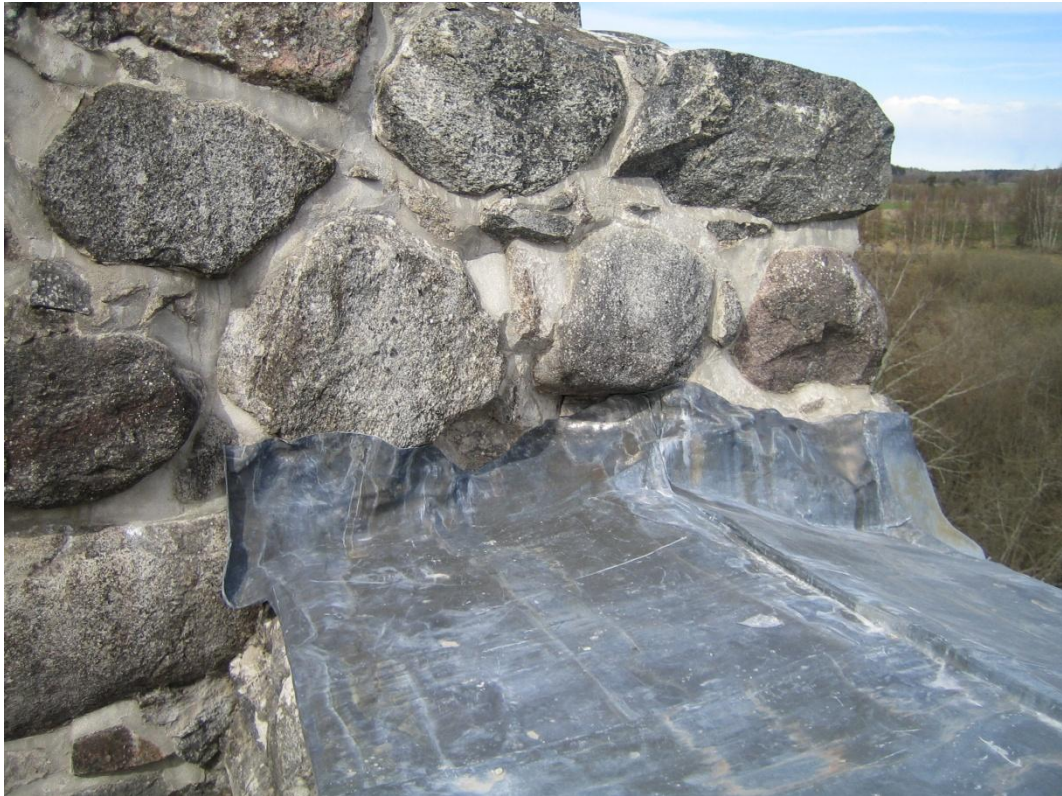
Bild 18. Färdigt blytäckningsarbete vid rum 121.
