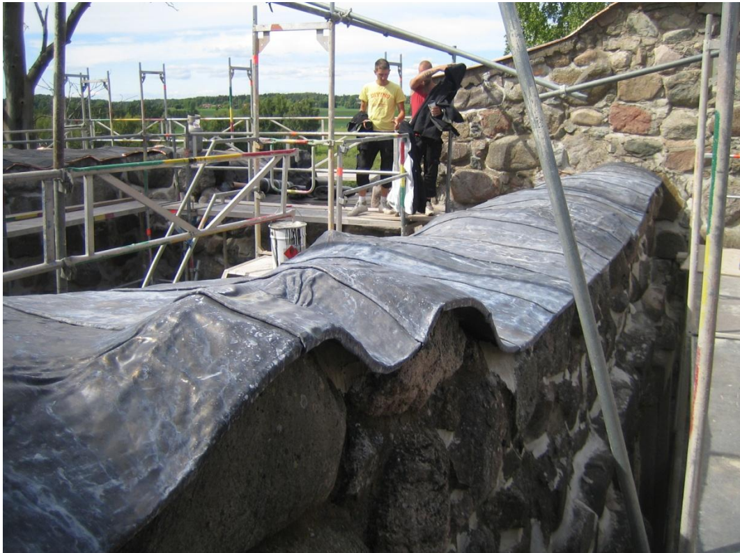
Bild 25. Färdig blytäckning i mellan rum 107 och 104.
