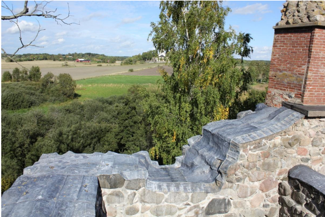
Bild 46. Färdig blytäckning mot väster och norr tillhörande rum 107.
