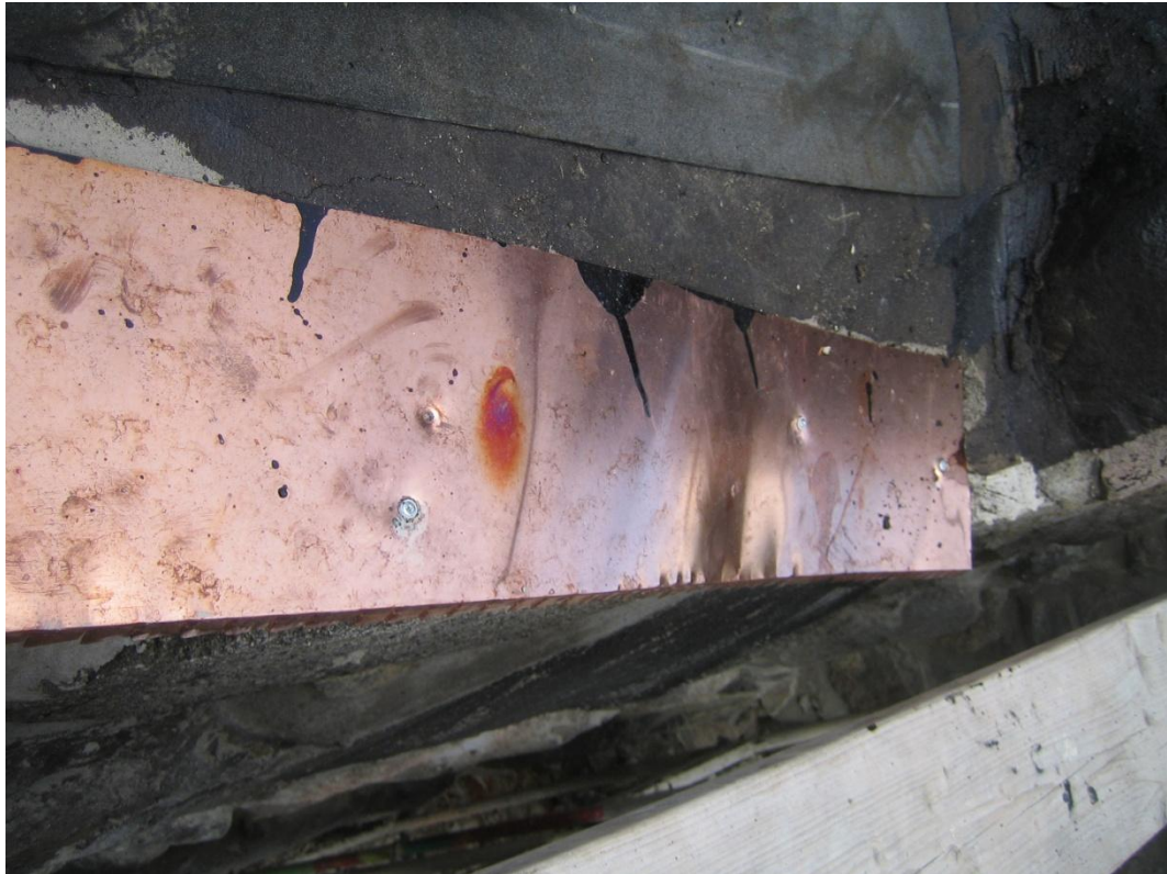
Bild 27. Pågående arbeten vid murkrön mot väster tillhörande rum 107.
