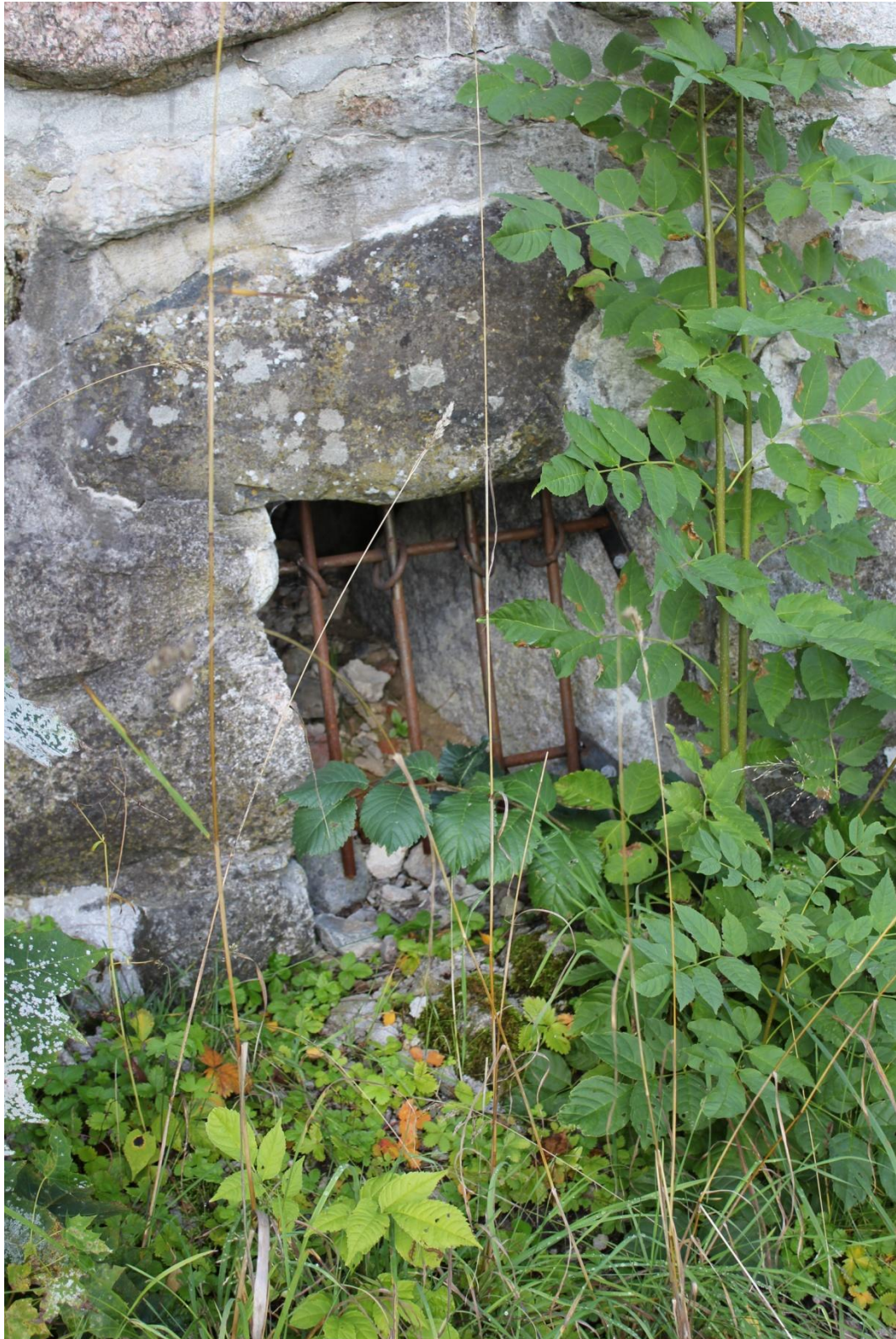
Bild 37. Nytt galler i öppning mot öster.
