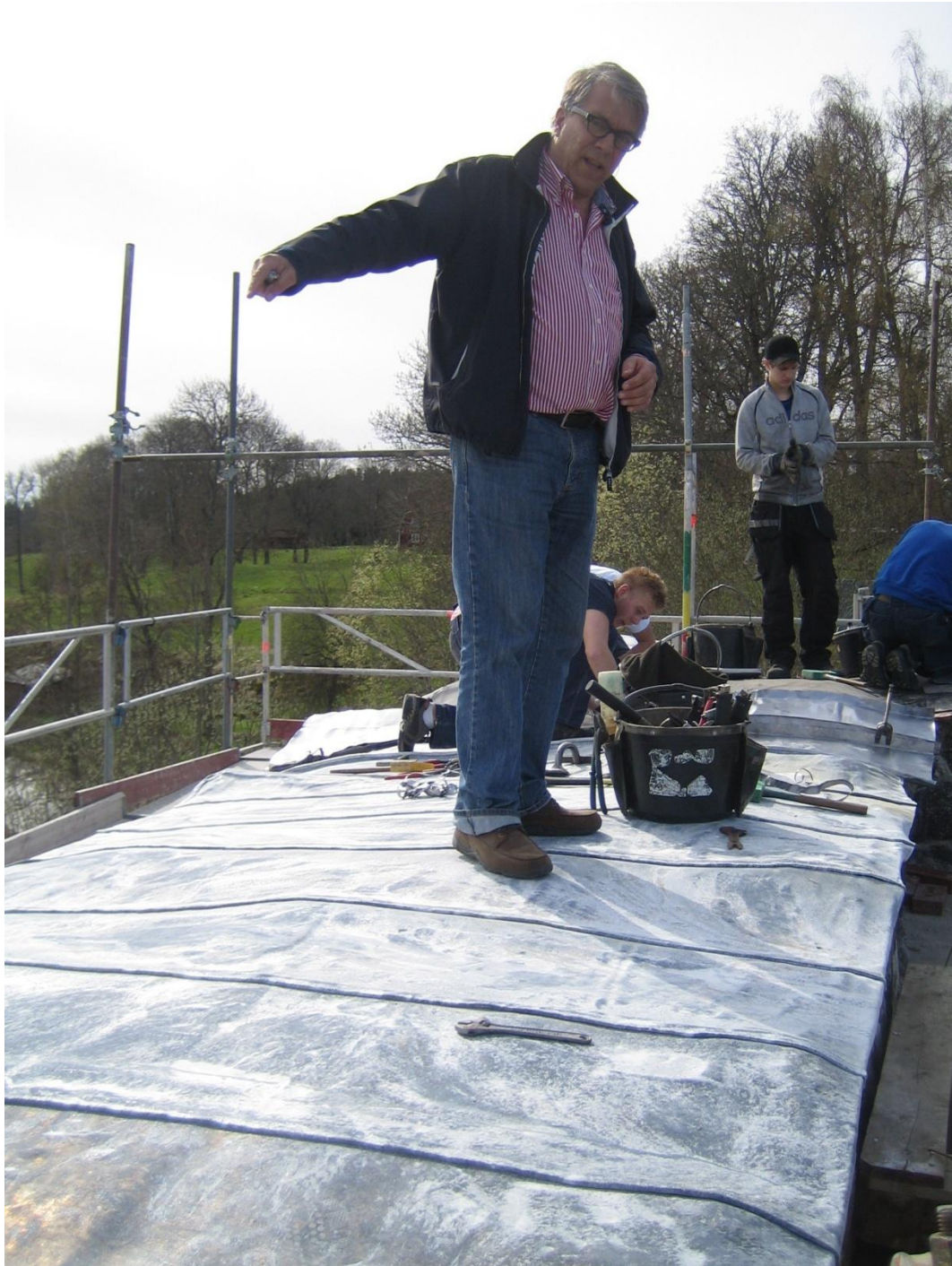
Bild 16. Pågående blytäckningsarbeten vid rum 121.
