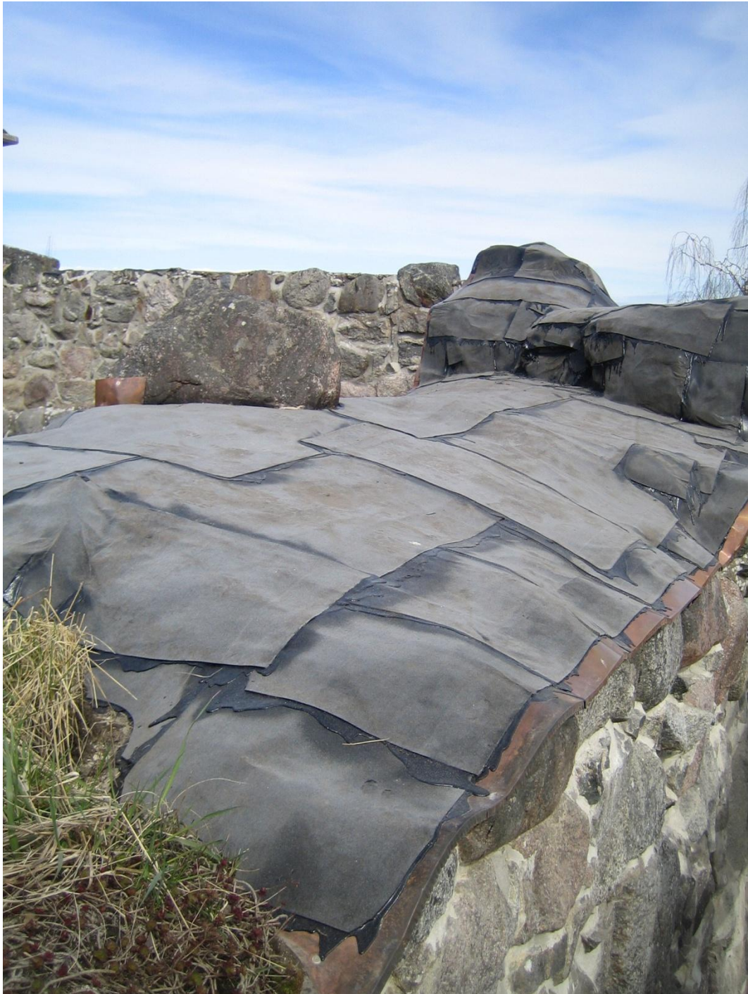
Bild 17. Pågående papptäckningsarbeten inför blytäckning vid rum 121 mot rum 220.
