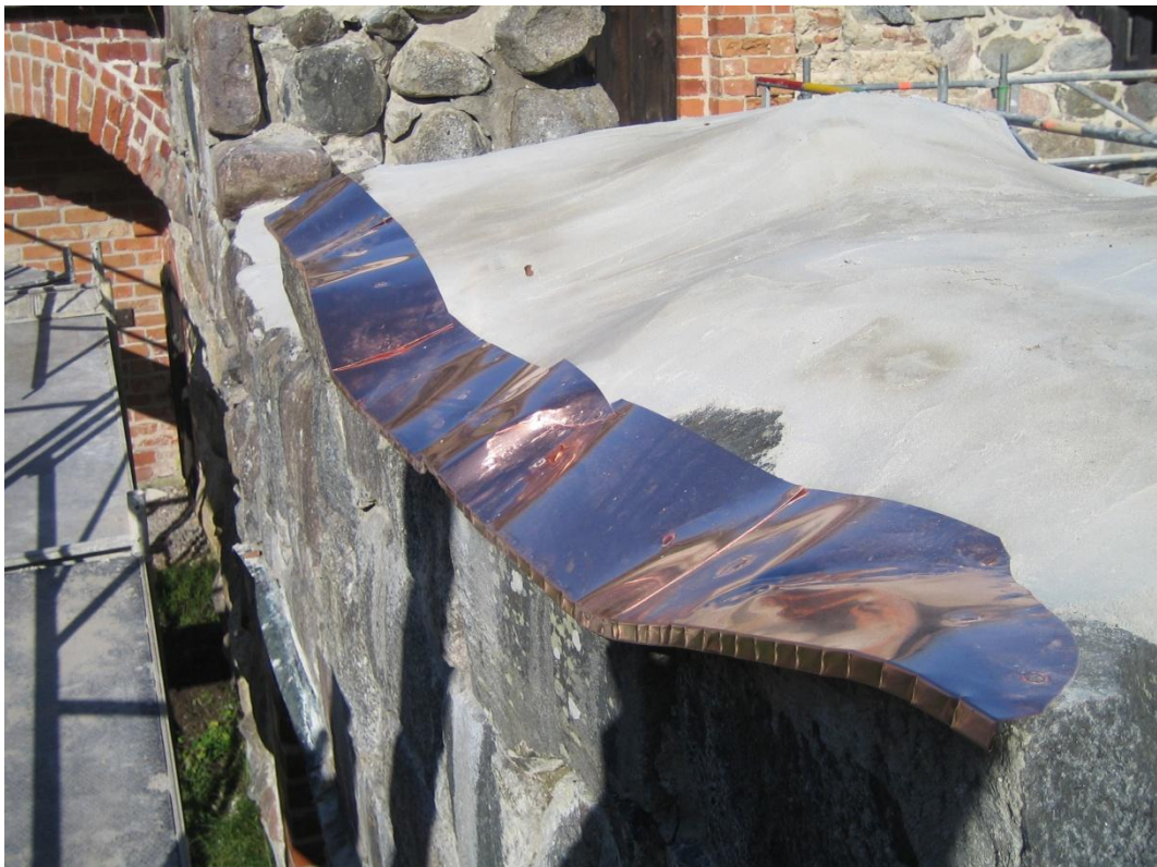
Bild 4. Provsträcka för ny blytäckning. Fästbleck av kopparplåt monterad.
