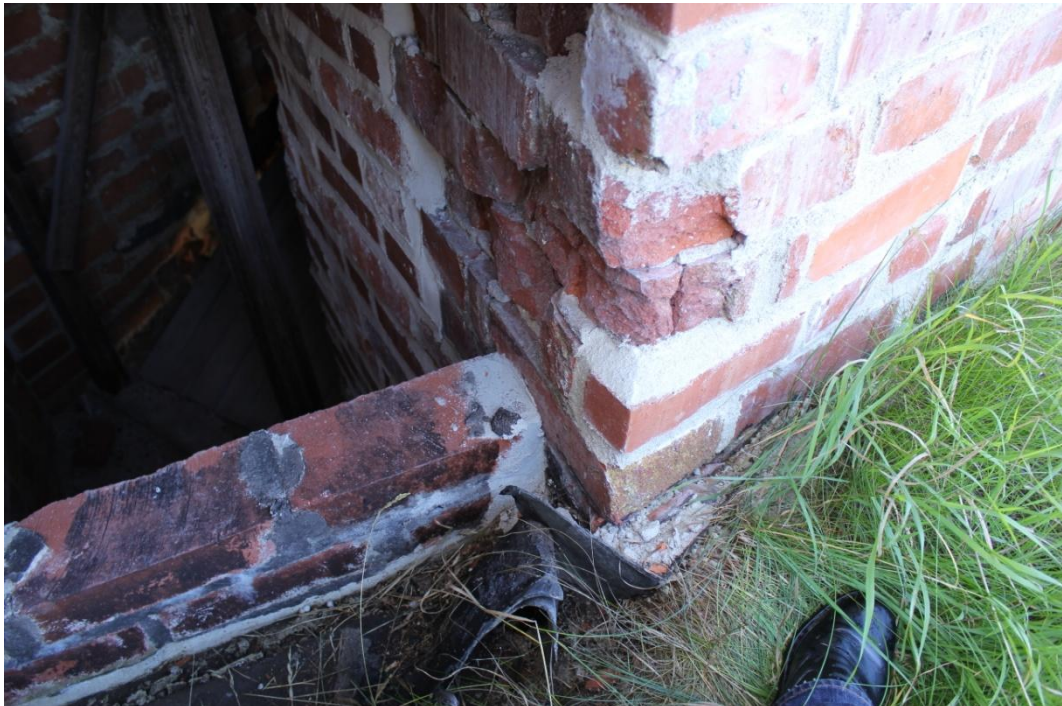
Bild 47. Murkrön enligt ritning Y5 som ej var färdigställt vid slutbesiktning. Pappläggning saknas.
