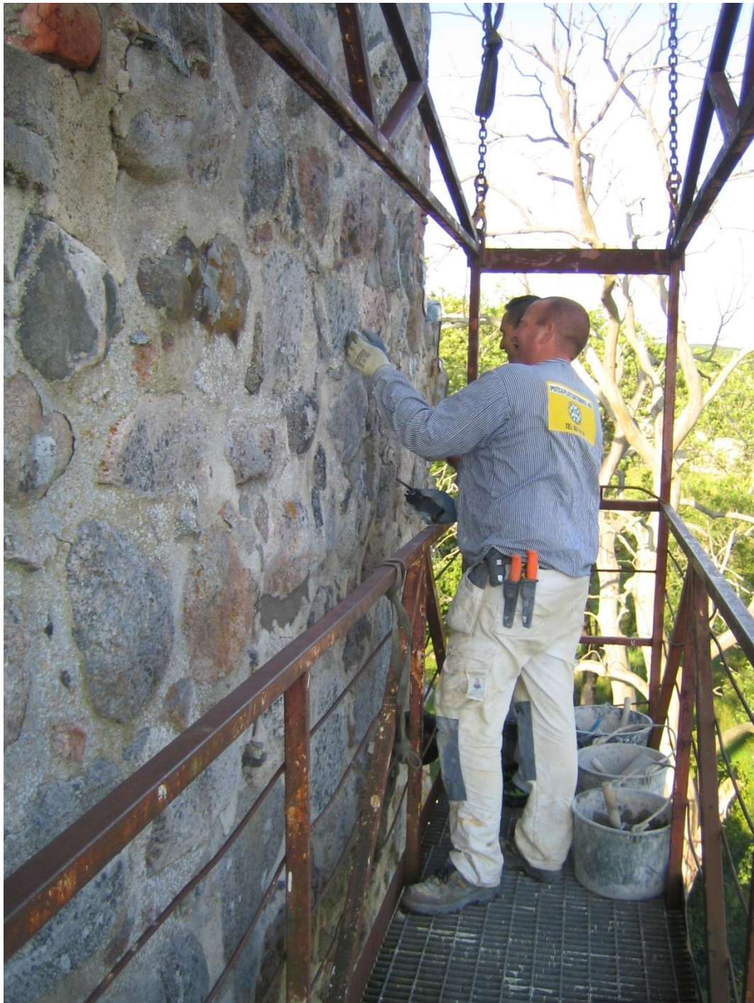
Bild 31. Foglagning på högdelen mot norr. Arbeten från hångorg.
