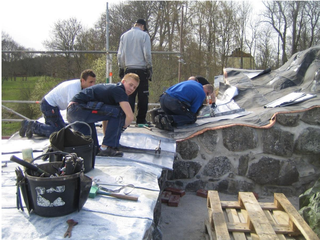
Bild 15. Pågående blytäckningsarbeten vid rum 121.
