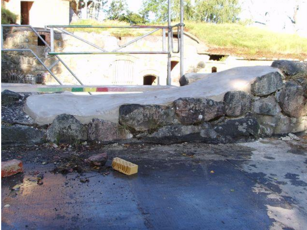
Bild 1. Provsträcka för ny blytäckning. Bruksavjämning utförd.
