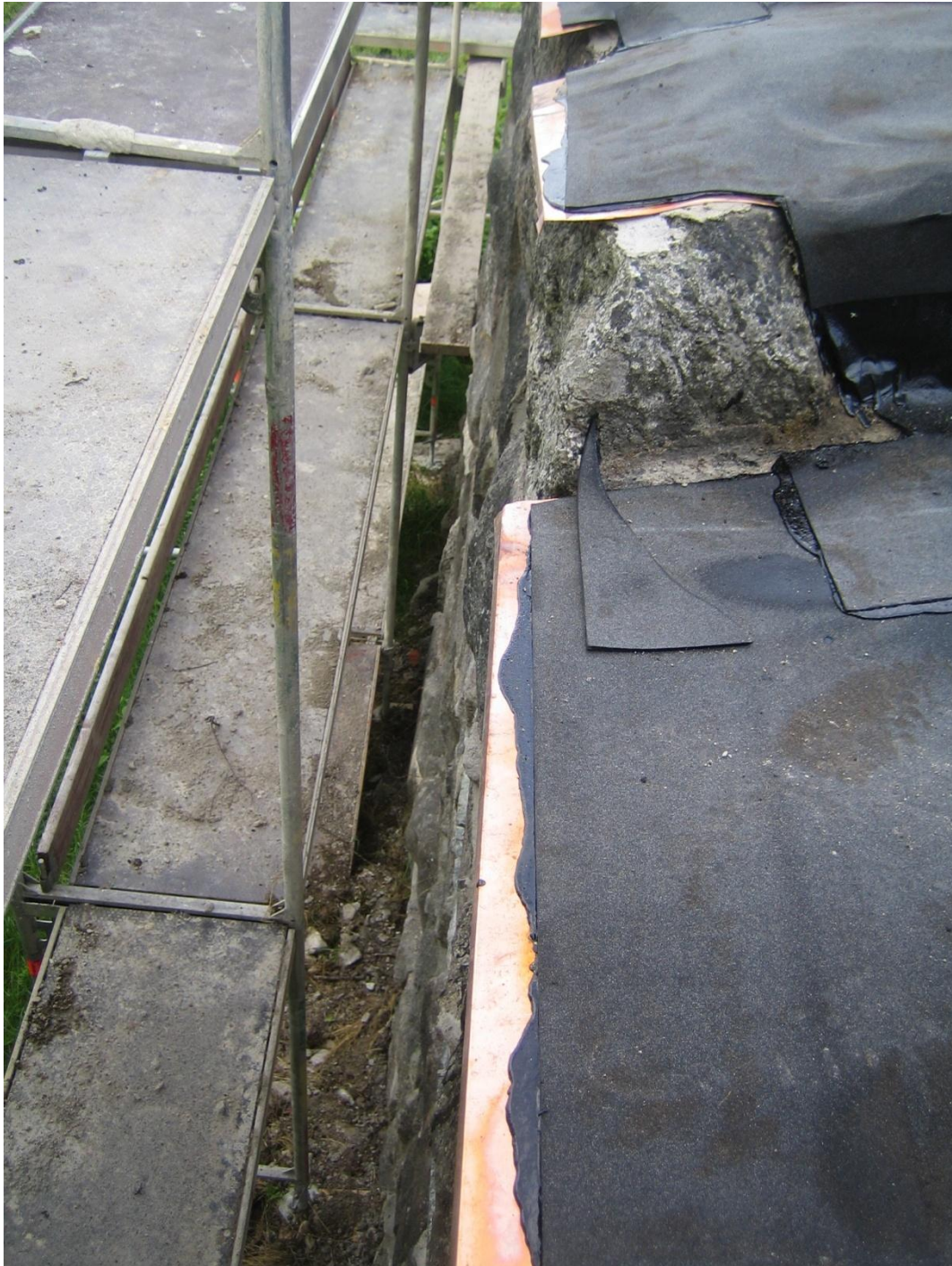
Bild 26. Pågående arbeten vid murkrön mot väster tillhörande rum 107.
