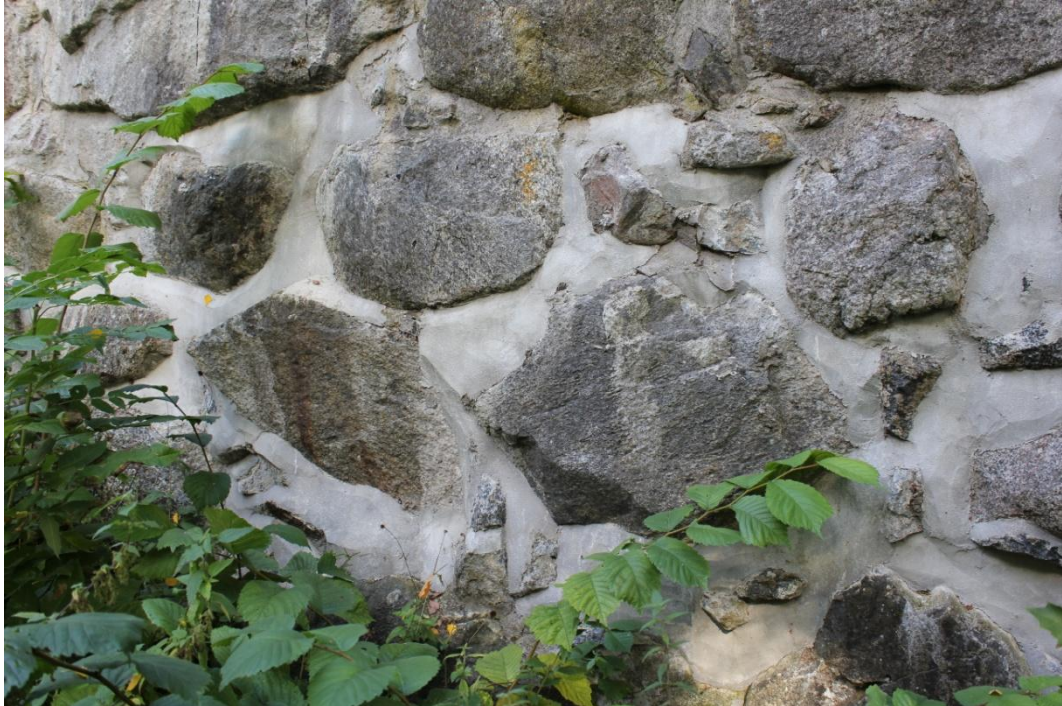
Bild 36. Foglagning utförd mot öster med pigmenterat bruk.
