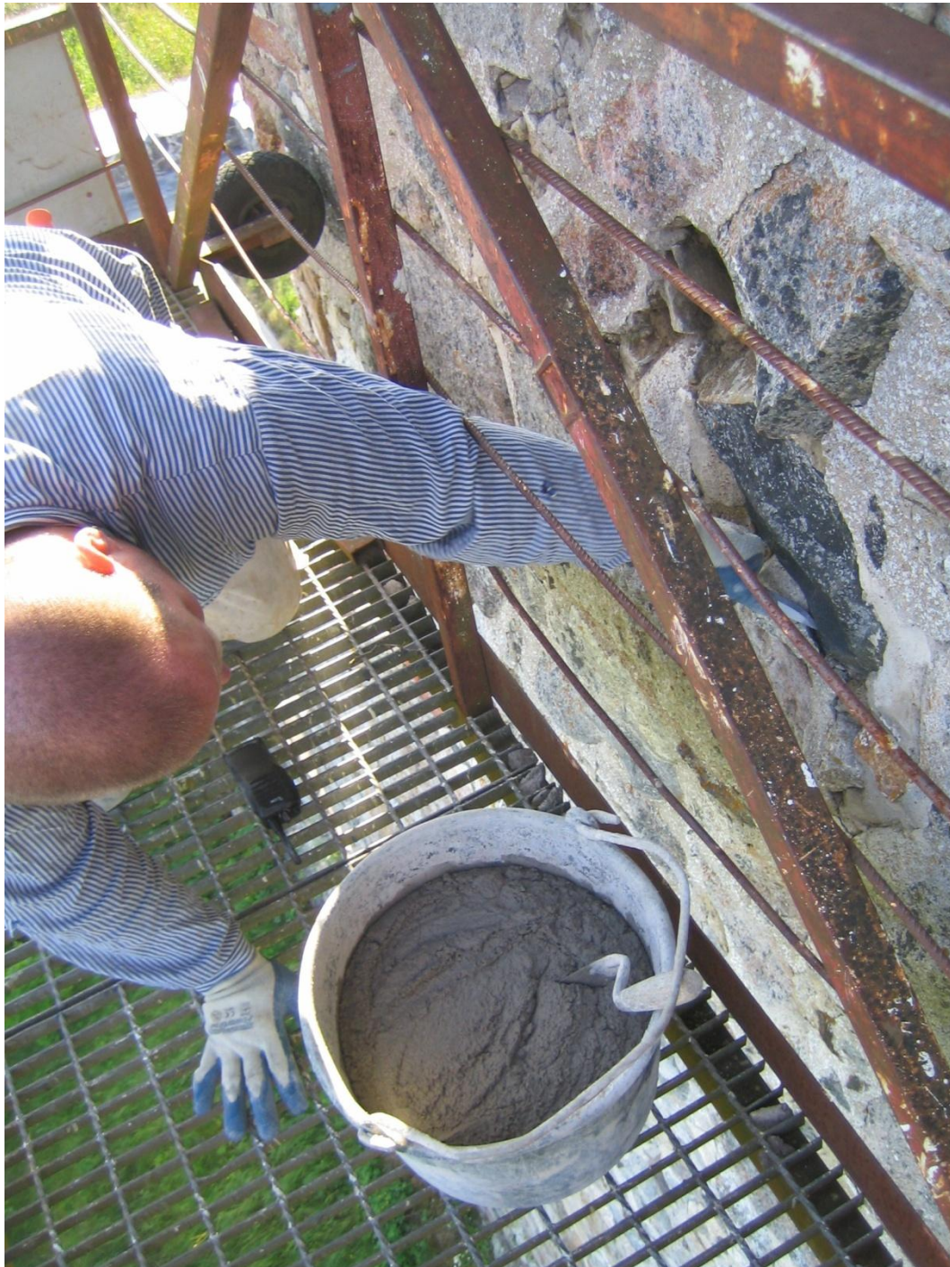
Bild 28. Foglagning på högdelen mot norr. Arbeten från hängkorg.
