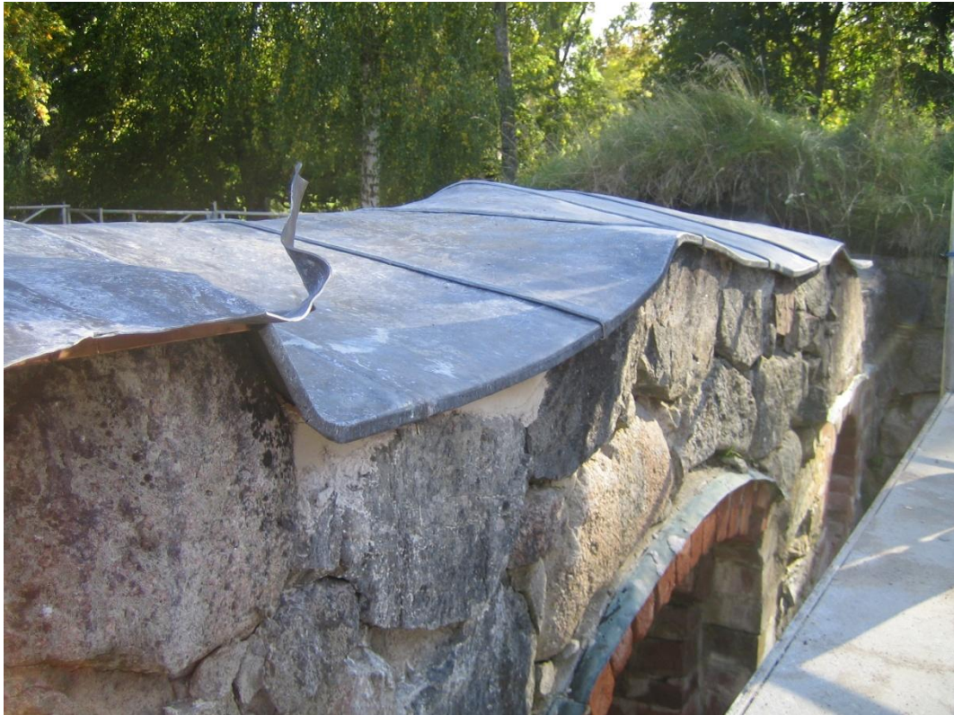
Bild 5. Provsträcka för ny blytäckning.
