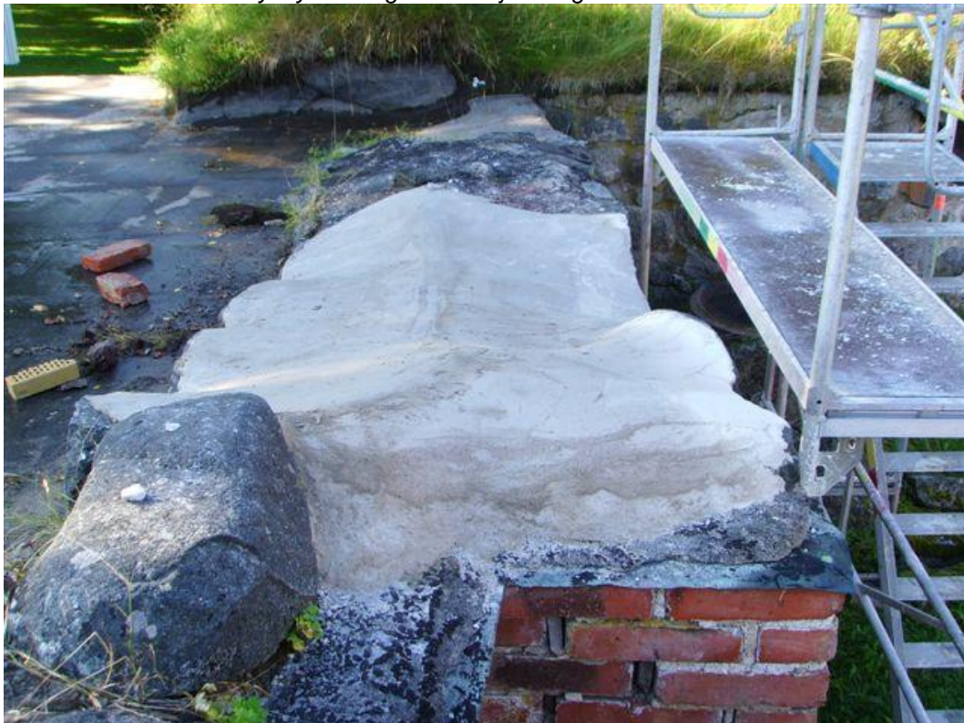
Bild 2. Provsträcka för ny blytäckning. Bruksavjämning utförd.
