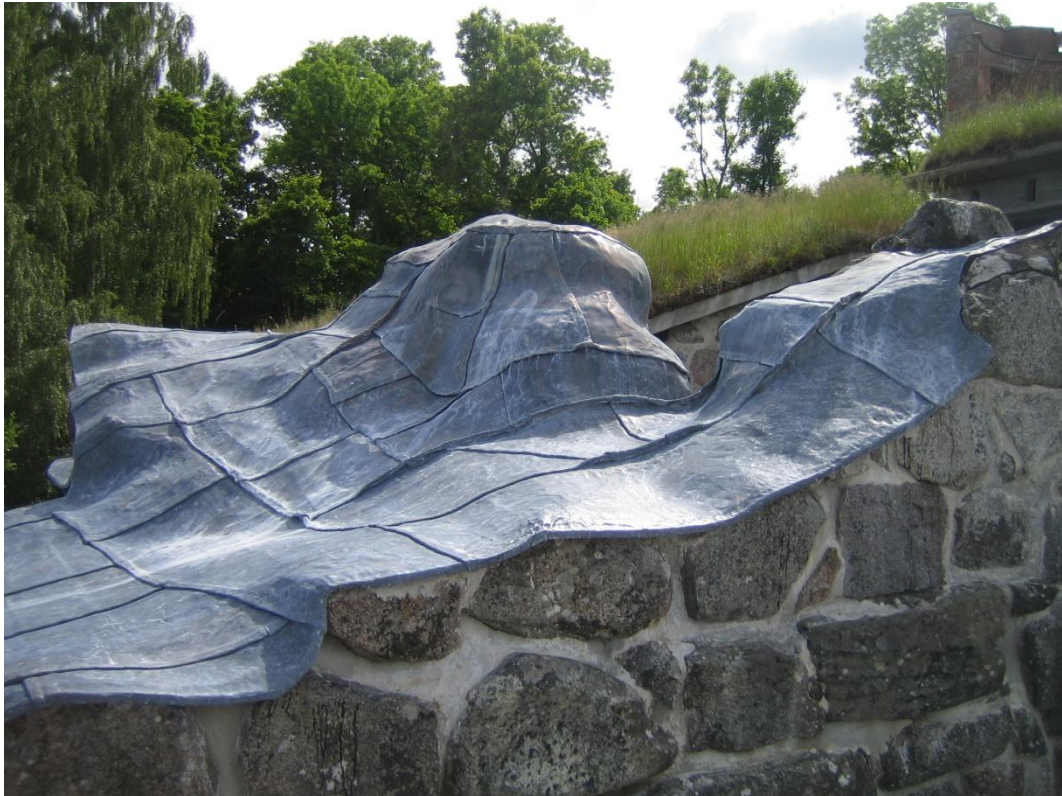
Bild 24. Färdig blytäckning i norra tornet.
