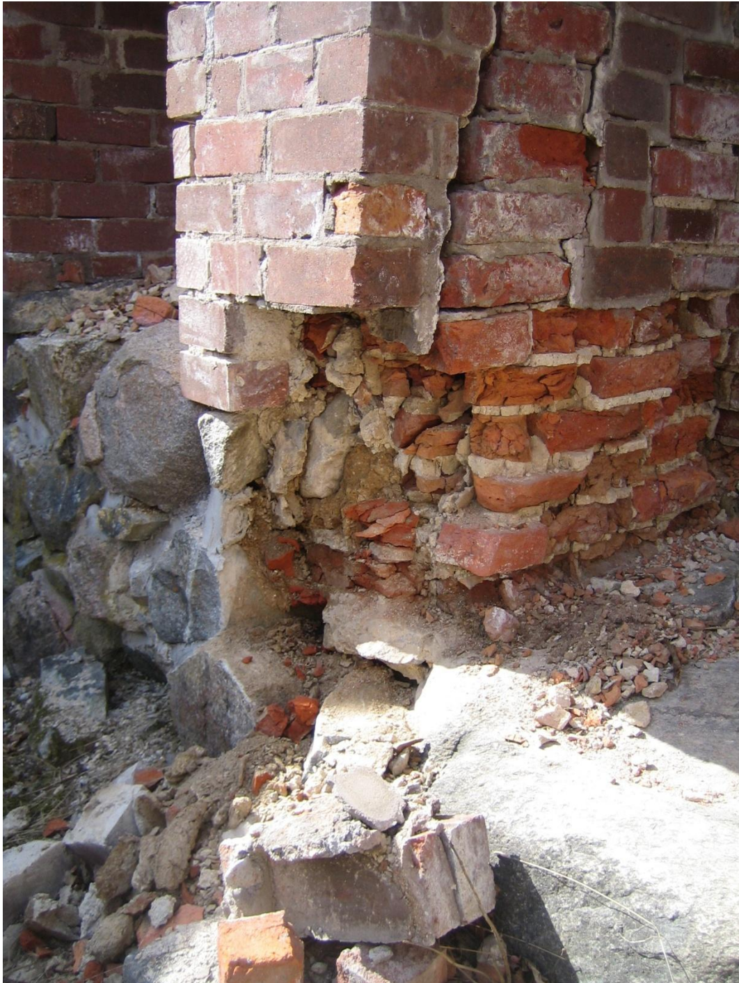
Bild 19. Bild av omfattning in till rum 117 tagen i maj 2010 före renovering.
