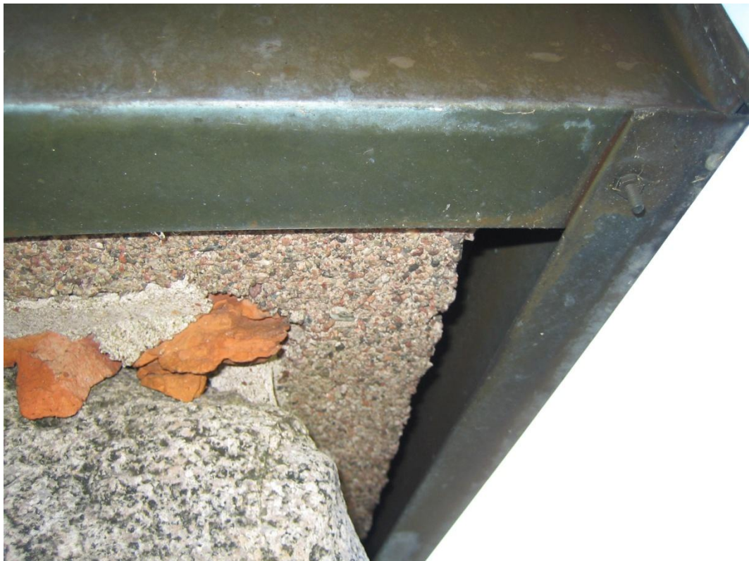
Bild 33. Krans över högdelen mot norr. Krans av betong täckt med kopparplåt.
