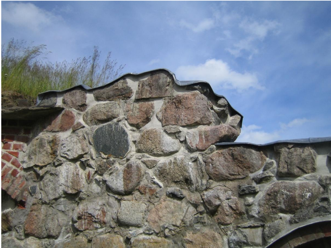
Bild 22. Blytäckning över murkrön in till rum 117. Blytäckning följer murkrönet väl.
