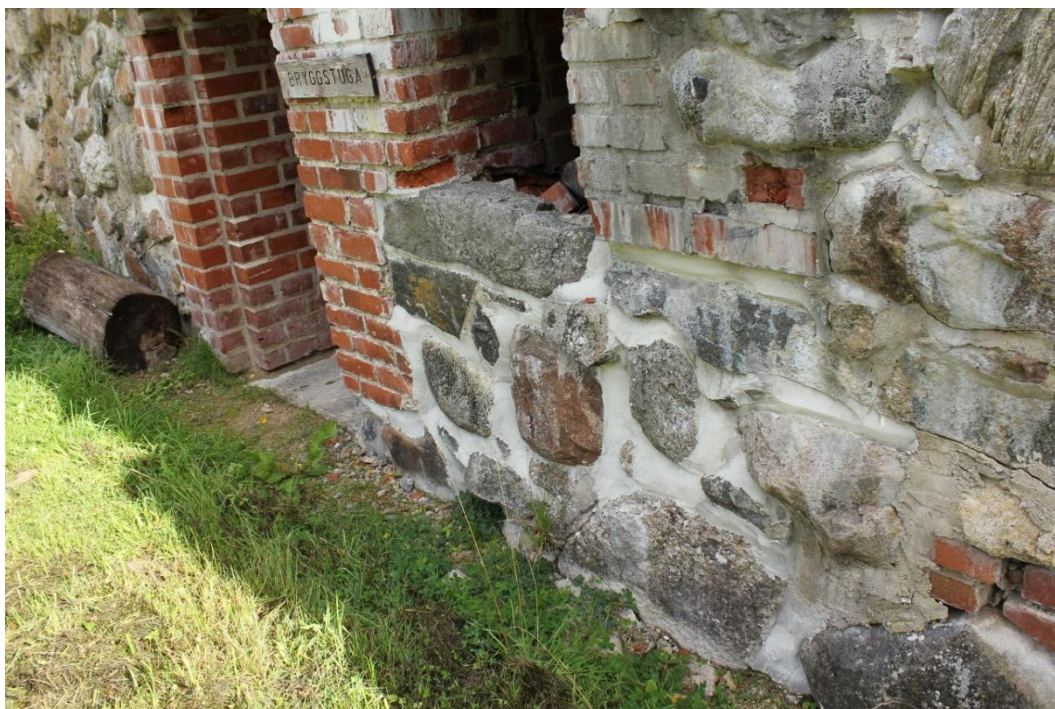
Bild 42. Foglagningsarbeten inne på borggården.
