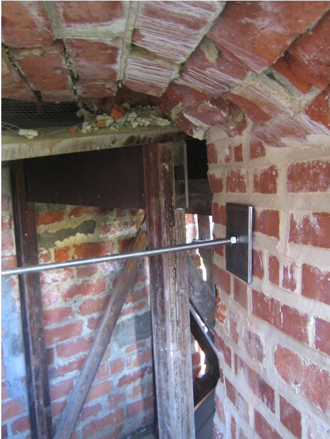
Bild 10. Genomgående infästning på östra sidan. Jämför bild 9.
