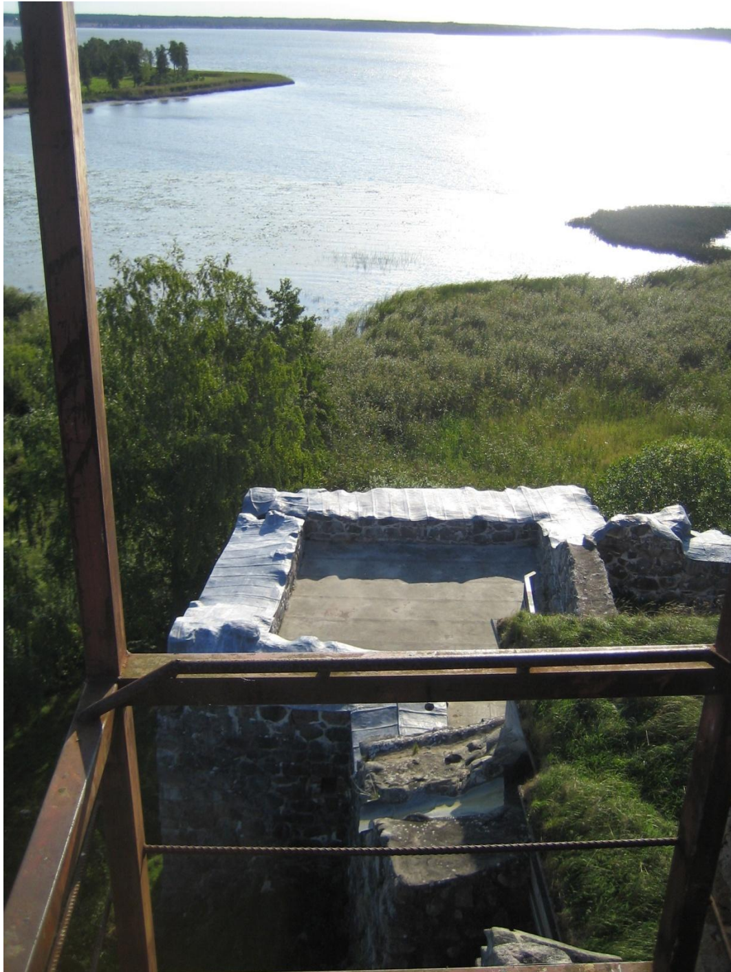
Bild 29. Vy från hängkorg över norra tornet och dess nya blytäckning.
