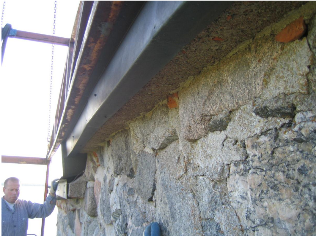
Bild 32. Krans över högdelen mot norr. Krans av betong täckt med kopparplåt.
