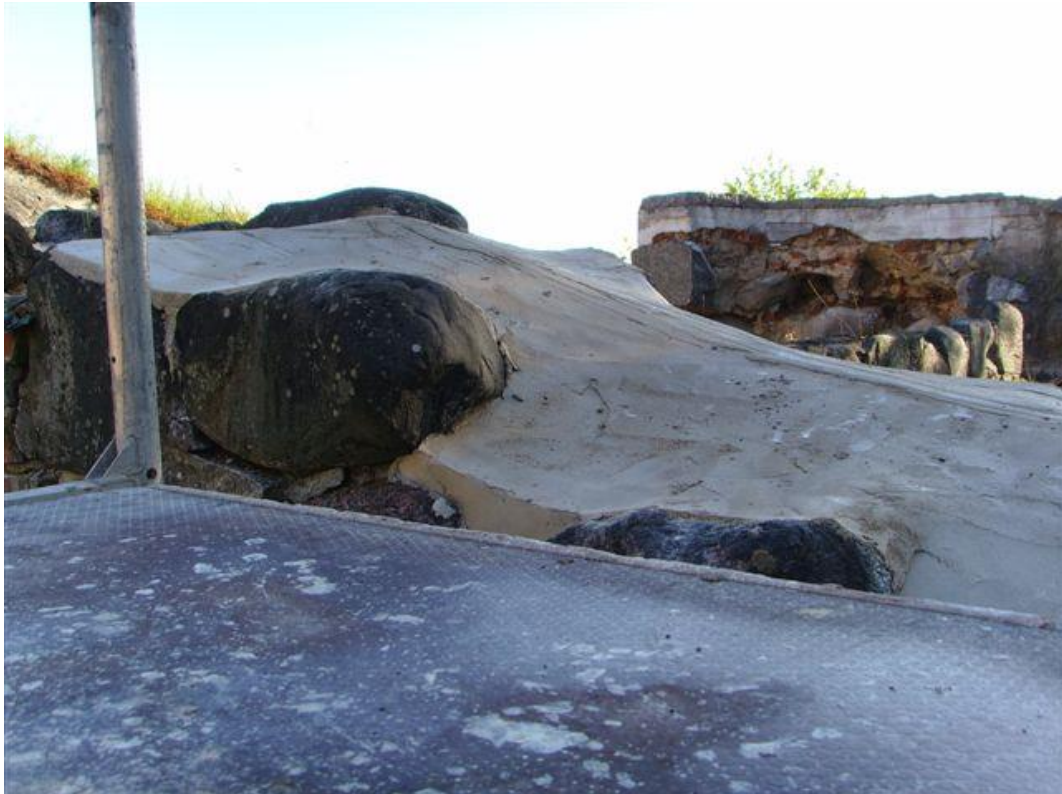
Bild 3. Provsträcka för ny blytäckning. Bruksavjämning utförd.
