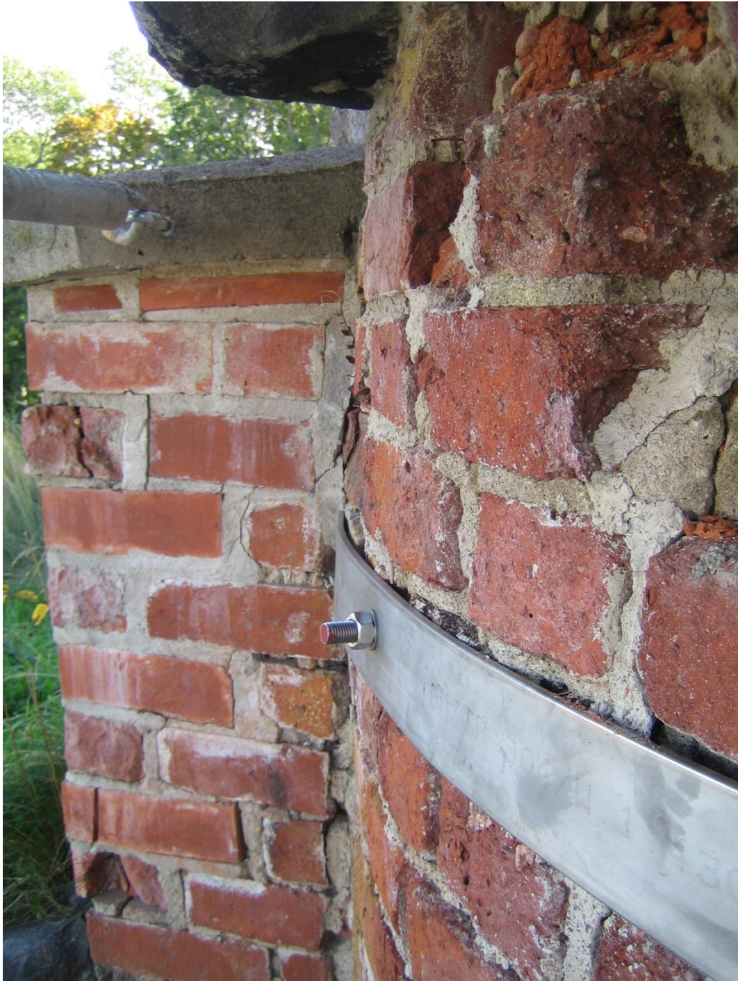
Bild 9. Genomgående infästning på östra sidan. Jämför bild 10.
