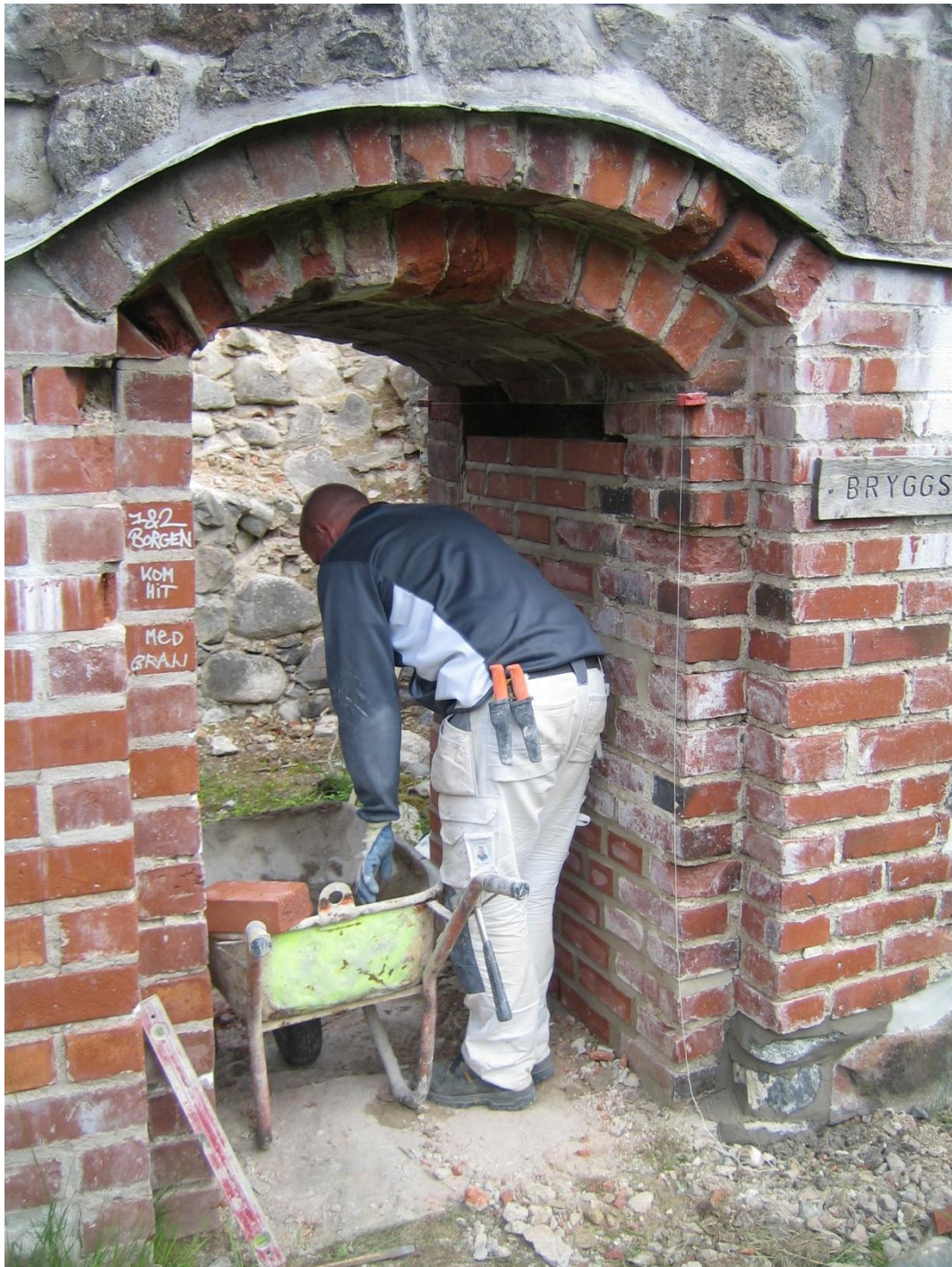
Bild 21. Pågående lagning i omfattning till rum 117.
