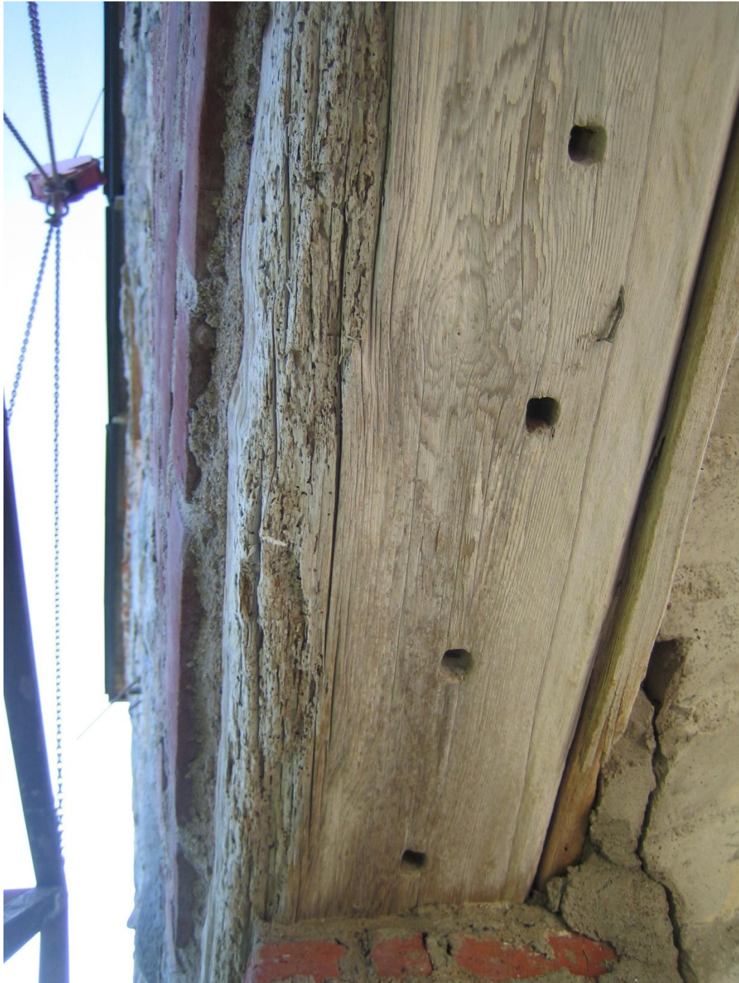
Bild 34. Vid öppning i norra högdelen sitter träbjälkar. Mot ytterkant något insektsangripna. Inga arbeten gjordes här.
