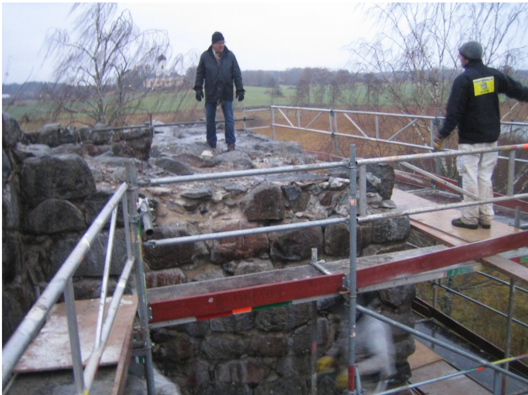
Bild 13. Pågående murkrönsarbeten vid rum 121. Stenar synligt släppt vid murkrönet.
