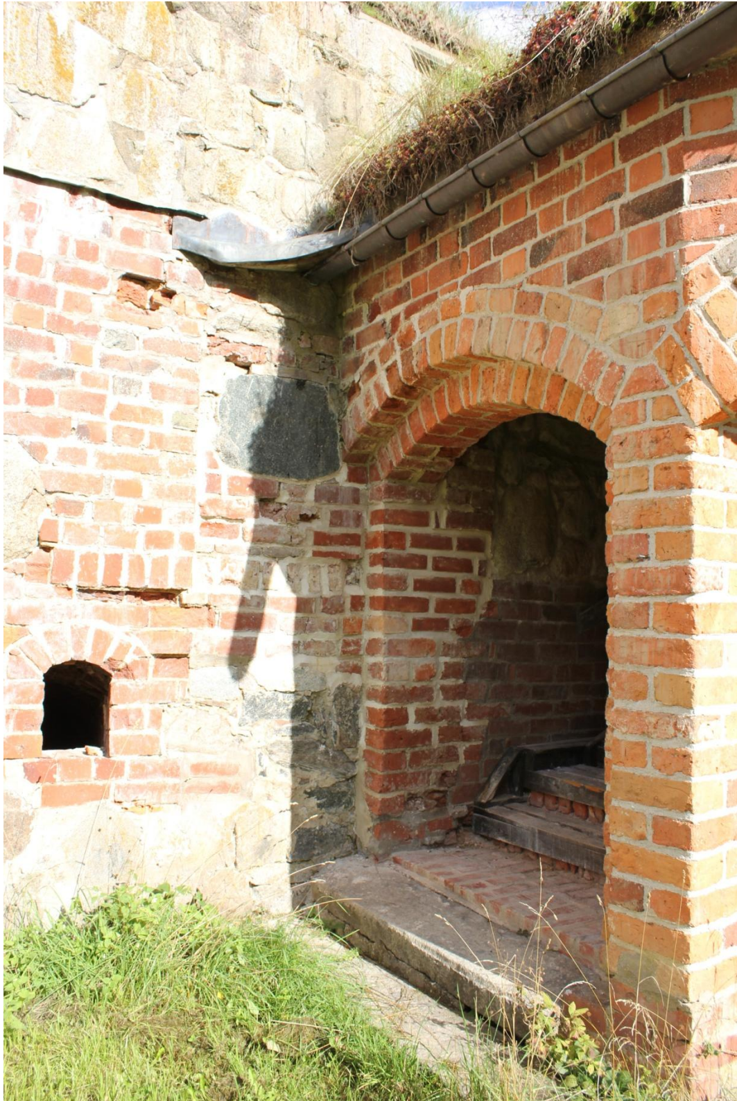
Bild 43. Foglagning och utbyte av frostsprängt tegel i öppning in till rum 119.
