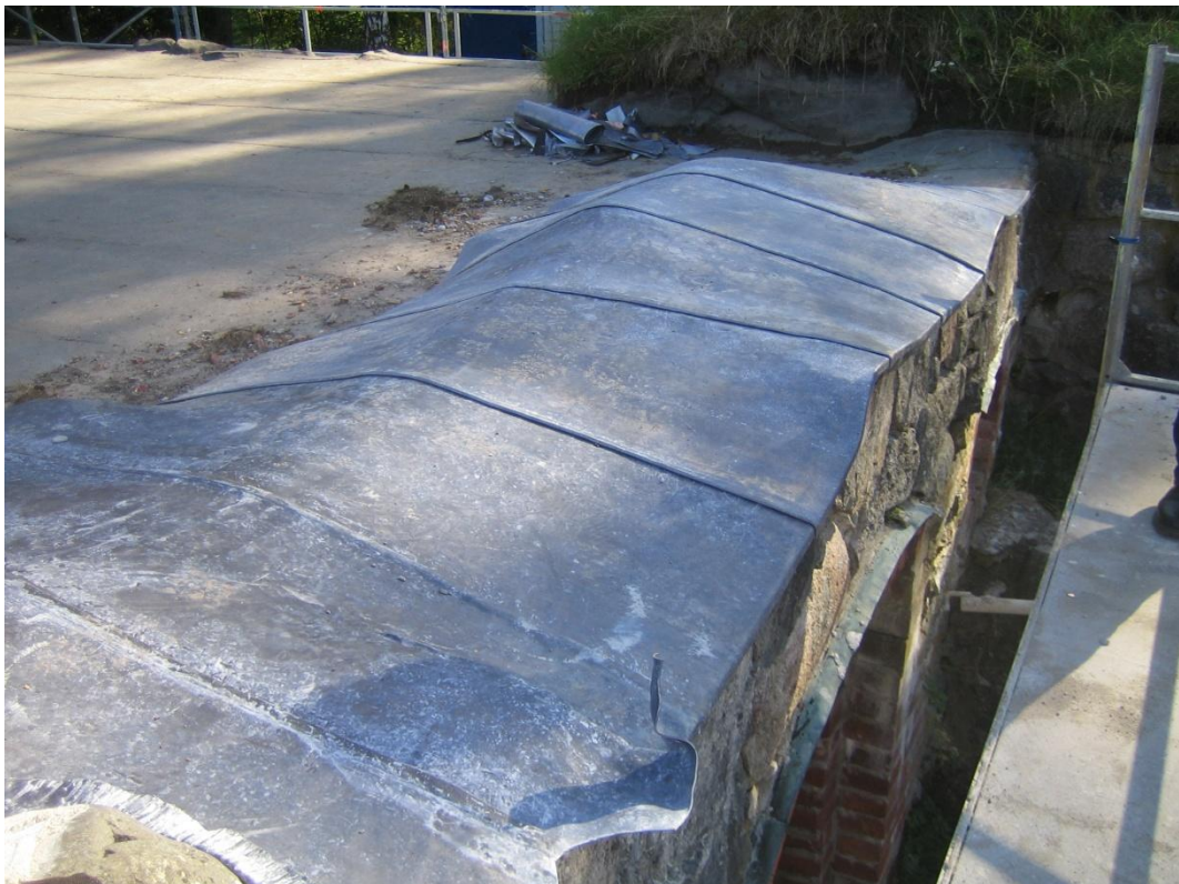
Bild 6. Provsträcka för ny blytäckning
