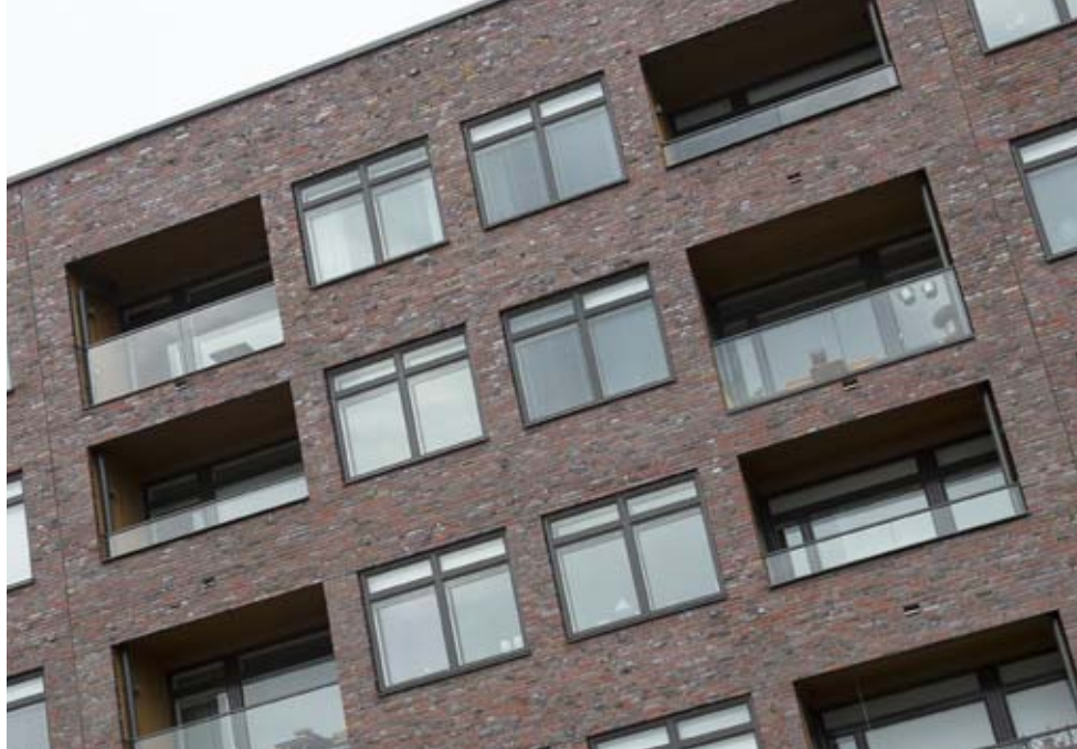
Uppdraget att mura fasaderna på den nya fastigheten i kv. Rackarbergen, vid Ringvägen i Stockholm, krävde specialbruk och stor yrkesskicklighet.
