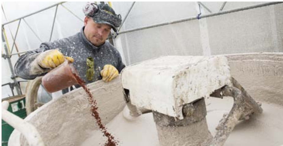
För att återskapa tullhusens ytstruktur och färgsättning tillverkar Puts & Plattsättning putsbruk enligt framtagna recept och färgprover.
