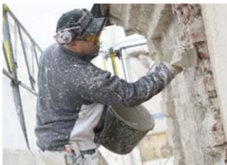
Stefan Janzon putsar fasaden på ett av tullhusen. Han berättar att de först mycket varsamt petade bort all dålig puts och sedan har fogat och putsat fasaderna.
