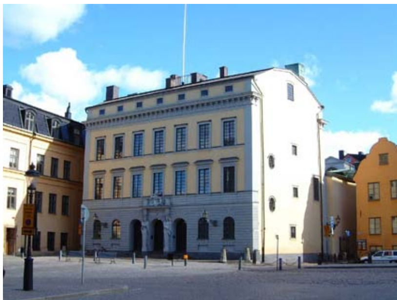
Även på det Tessinska palatset på Slottsbacken utförde Puts & Plattsättning puts- och stenrenovering och avfärgning med Gotlandskalk samt fönsterrenovering.
