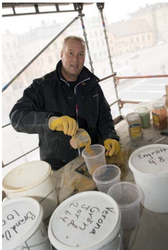
– En utmaning för oss är färgsättningen av putsbruket. Säkert har vi gjort 25 olika färg- och putsprover på slottets södra fasad, berättar murare Peter Karletun.
