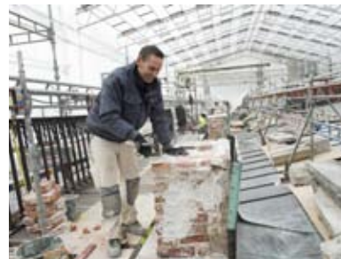
Tomas Löw är en av fyra murare från Puts & Plattsättning som arbetar på slottet.
