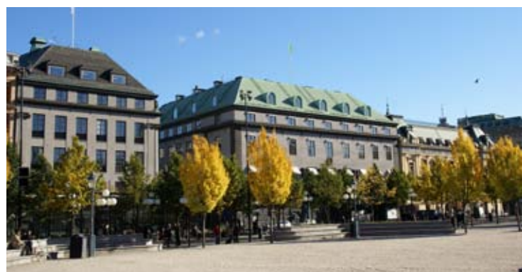
Renoverade fasader på Kungsträdgårdsgatan 6-10 i Stockholm, från höger Jernkontorets gamla hus, SE-bankens huvudkontor och Jernkontorets nya hus. Renoveringen utfördes med start från höger mellan åren 2003 och 2010.
