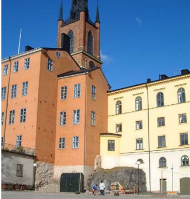
Puts & Plattsättning utförde putsrenovering och avfärgning med Gotlandskalk samt fönsterrenovering på det Sparreska palatset på Riddarholmen.
