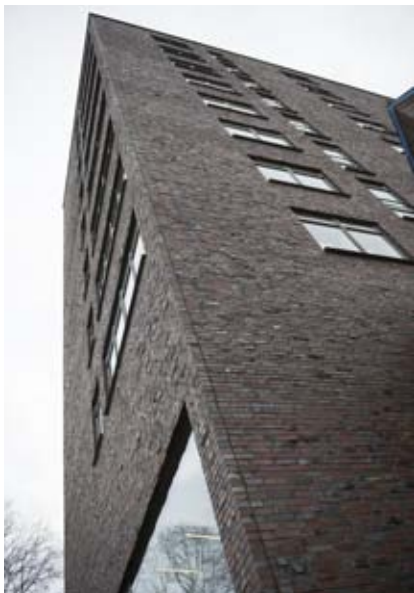
Uppdraget att mura fasaderna på den nya fastigheten i kv. Rackarbergen, vid Ringvägen i Stockholm, krävde specialbruk och stor yrkesskicklighet.
