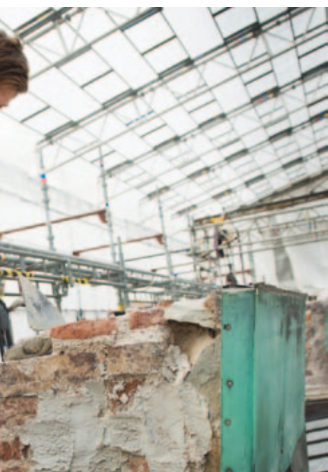
här med lagning och bakmurning.
